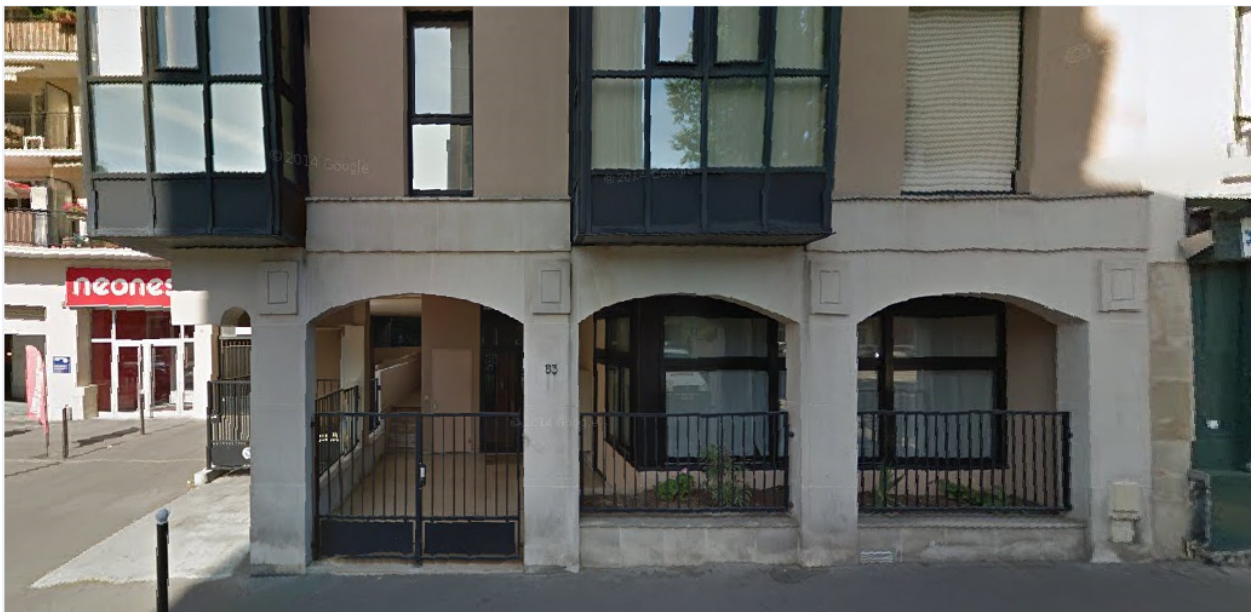
Rue de Lagny, Paris
